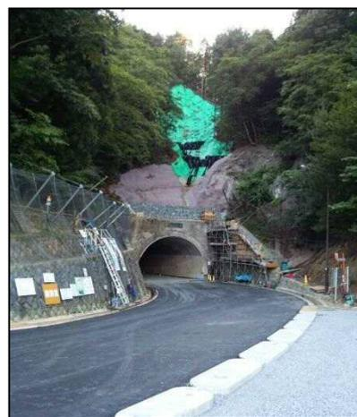
(2)本線盛土が約30mにわたり崩壊。盛土により再構築し、本復旧工事が完了。
